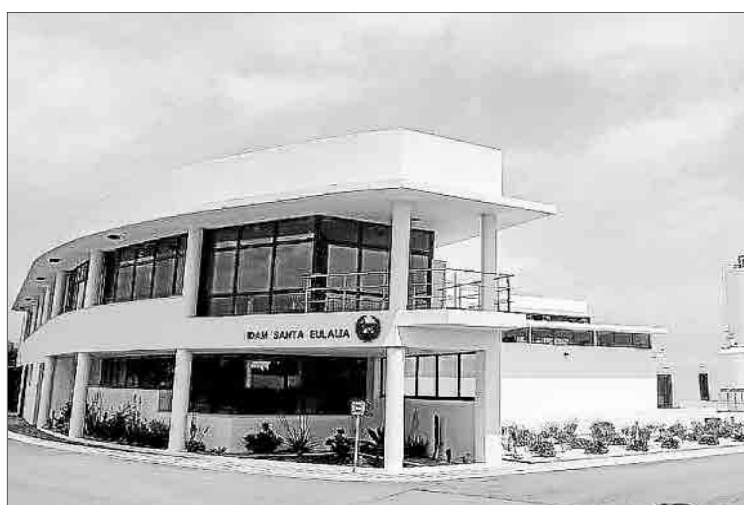
Imagen de archivo de la desaladora de Santa Eulària.
