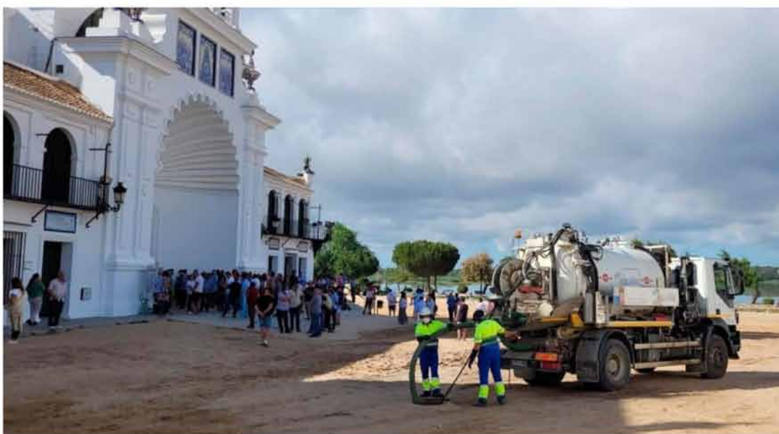
Desatascos preventivos en el saneamiento para la romería del Rocío (Huelva).
