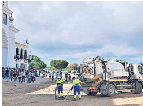
Aqualia en labores de desatascos preventivo y saneamiento en el Rocío.
